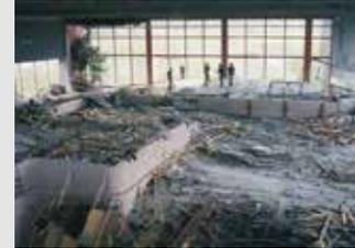
Nel 1985 a Uster (Svizzera), il controsoffitto sospeso in calcestruzzo di una piscina coperta è crollato. Gli elementi di sospensione del controsoffitto, in acciaio inossidabile, non mostravano alcun difetto esterno, ma in alcuni casi internamente erano completamente distrutti dalla corrosione sotto tensione.
