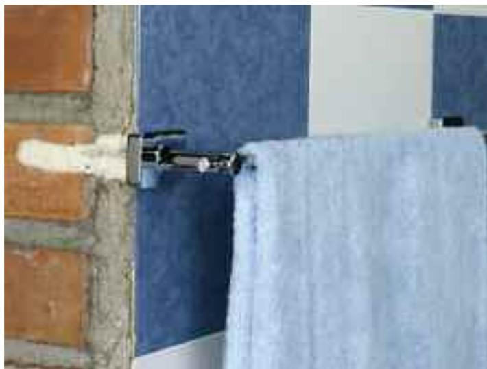
Può capitare che per un montaggio non esattamente a regola d'arte o per l'azione accidentale di uno sforzo eccessivo, un tassello perda tenuta e diventi lasco nella sua sede, o meglio, il supporto (muro, intonaco, ecc) si sgretoli quel tanto che basta a comprometterne la tenuta.
