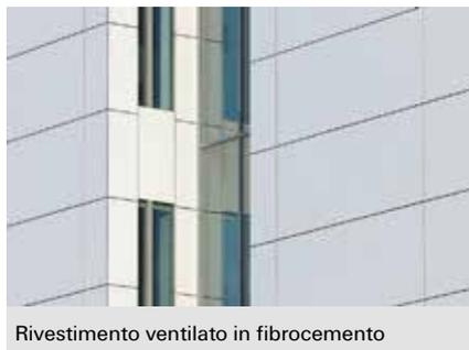
Rivestimento ventilato in fibrocemento
