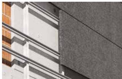
Sottostruttura montanti e trasversi
