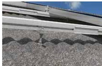
Dettaglio: vite STSI con staffa SSP
